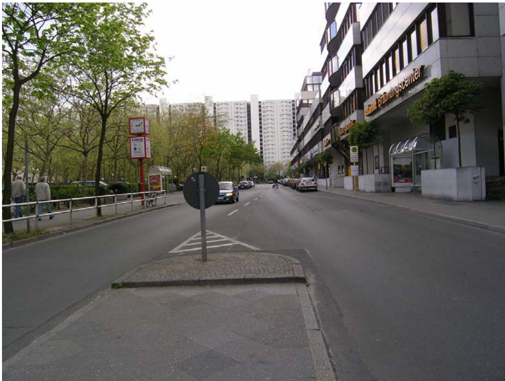
Bild 4-8 Tempo-30-Zone wird nicht deutlich: überbreite Fahrbahnen, Gitter, schmale Gehwege auch an der Bushaltestelle, unbefriedigende Gestaltung des Straßenraums; Erschließungsfunktion der Straße überlagert sich mit Zugang zum Einkaufszentrum.
